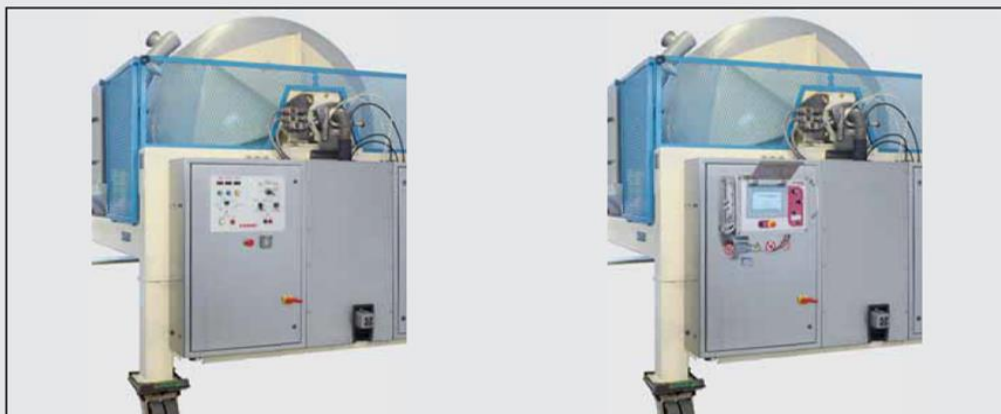
Замена электрического шкафа для машин Diemme Enologia и других брендов с новой панелью из нержавеющей стали
